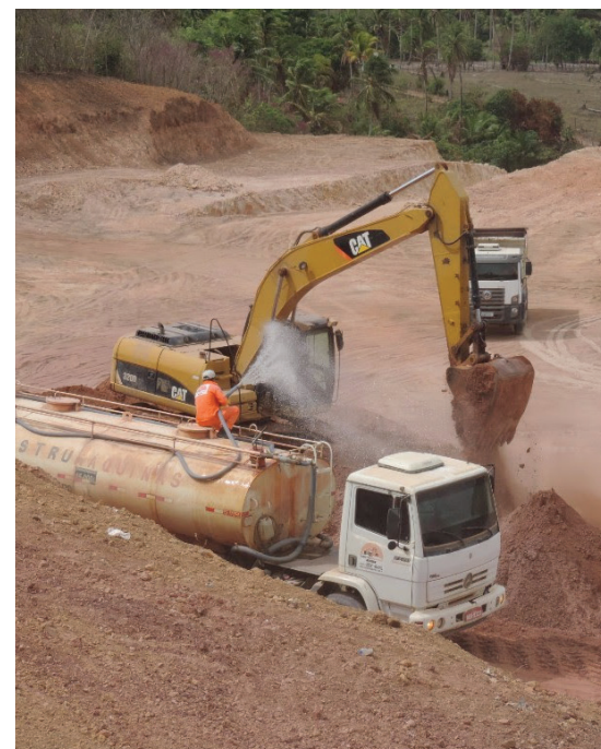
As obras da ETE Jaguaribe estão previstas para o início do próximo ano
